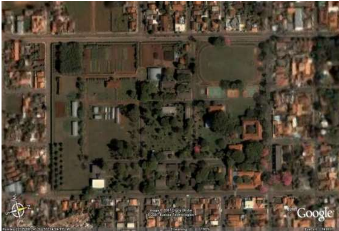
Imagem de satélite do Campus Urbano. (Fonte: http://www.googleearth.com.br )
